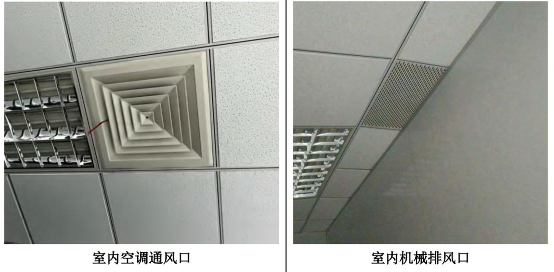
**图 10-10 项目 CT 室的通排风装置（现已设有）**
