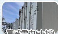
富威電力(土城)
